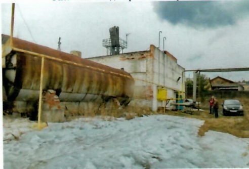
Рис. 4.111 Общий вид здания котельной
