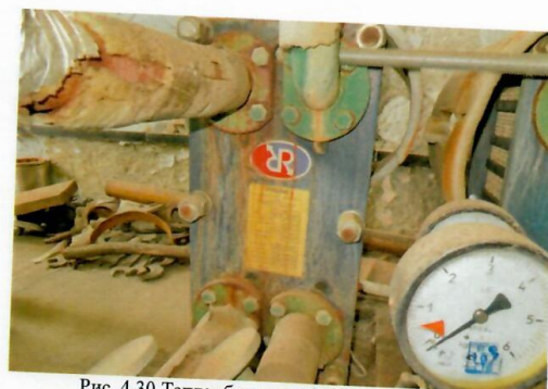
Рис. 4.30 Теплообменники ГВС пластинчатые
