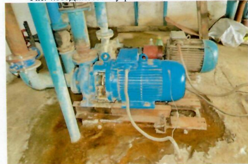
Рис. 4.112 Насосы сетевые
