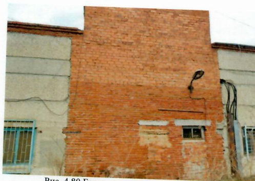
Рис. 4.80 Боковая стена здания котельной
