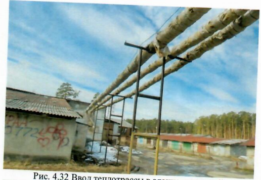
Рис. 4.32 Ввод теплотрассы в здание котельной
