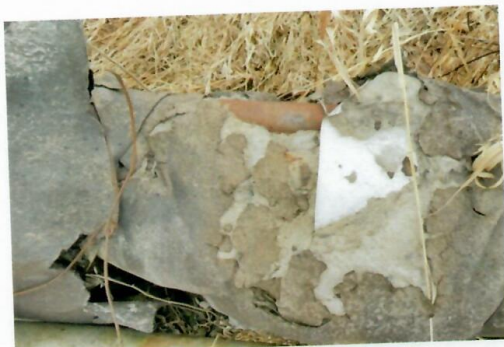
Рис. 4.133 Разрушение теплоизоляции
