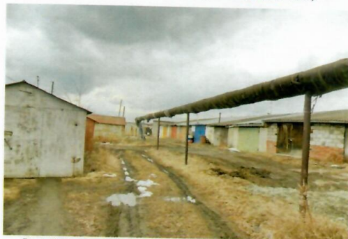
Рис. 4.59 Надземный участок магистральной теплосети
