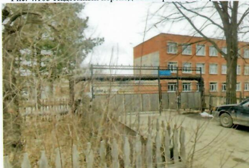
Рис. 4.105 Въезд на территорию училища к котельной
