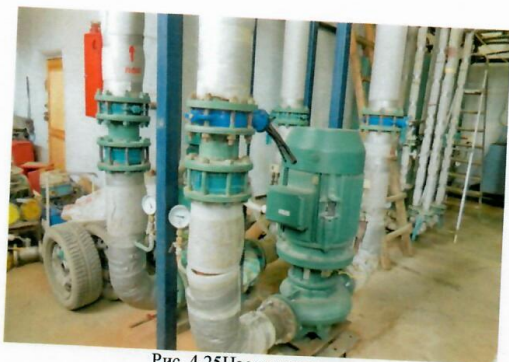
Рис. 4.25 Насосы сетевые
