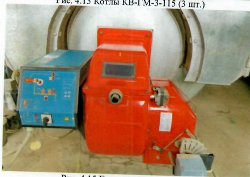
Рис. 4.15 Горелка газовая Unigas
