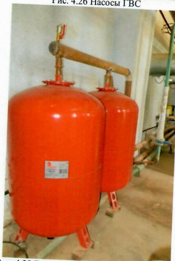
Рис. 4.28 Баки мембранные расширительные
