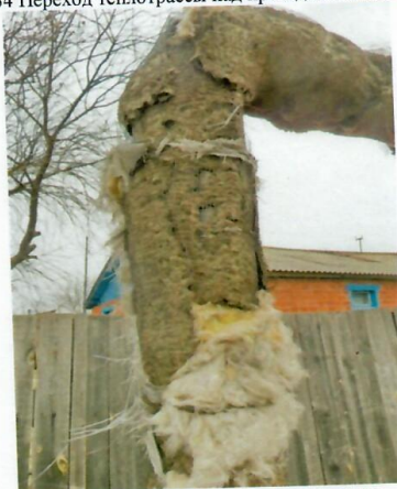
Рис. 4.136 Разрушение теплоизоляции
