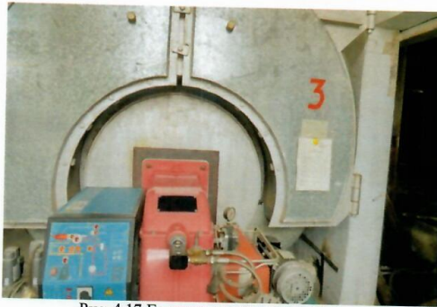
Рис. 4.17 Горелка газодизельная Unigas
