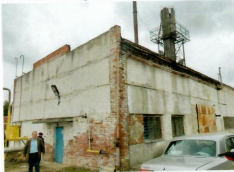
Рис. 4.107 Общий вид здания котельной
