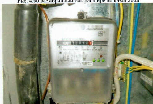
Рис. 4.92 Прибор учета электроэнергии
