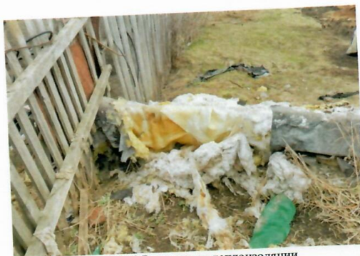
Рис. 4.139 Разрушение теплоизоляции
