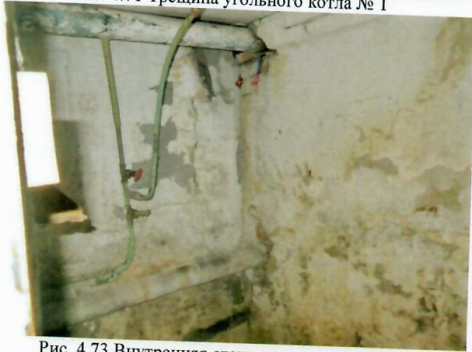
Рис. 4.73 Внутренняя стена здания котельной
