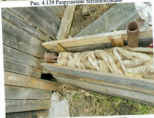
Рис. 4.141 Разрушение теплоизоляции
