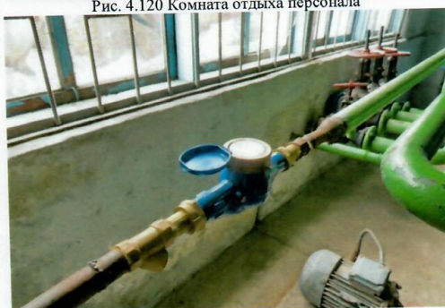
Рис. 4.122 Счетчик воды
