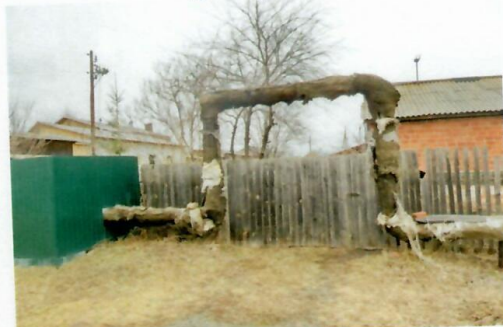
Рис. 4.134 Переход теплотрассы над проездом к жилому дому
