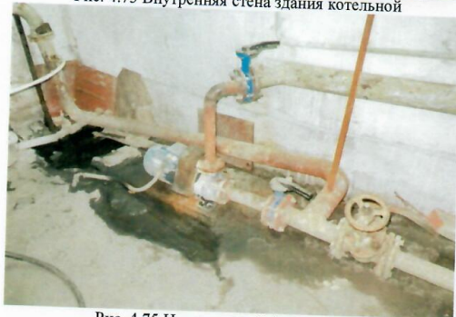
Рис. 4.75 Насос сетевой 1 (основной)
