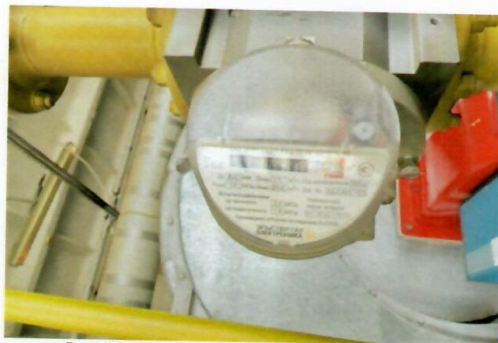
Рис. 4.21 Прибор учета расхода газа котла № 3
