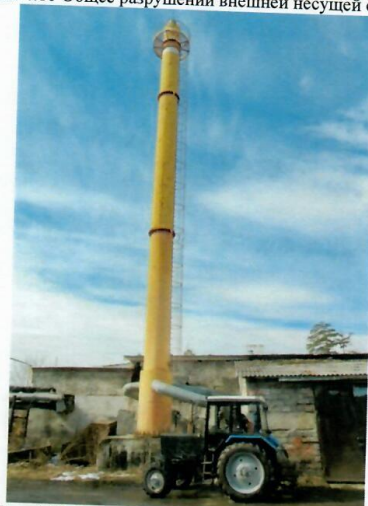
Рис. 4.12 Дымовая труба (установлена в 2006г.)
