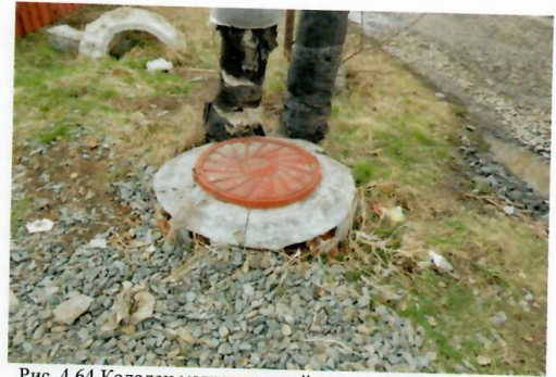
Рис. 4.64 Колодец магистральный тепловой сети Т1иТ2
