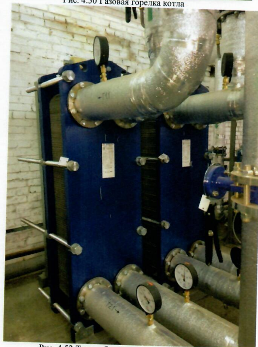
Рис. 4.52 Теплообменное оборудование
