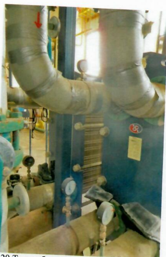
Рис. 4.29 Теплообменники отопления пластинчатые
