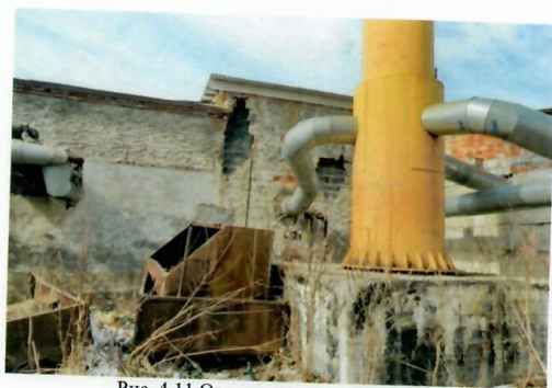
Рис. 4.11 Основание дымовой трубы
