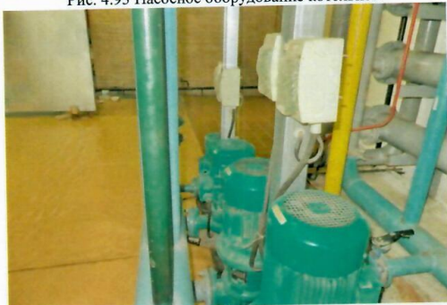
Рис. 4.95 Сетевые насосы
