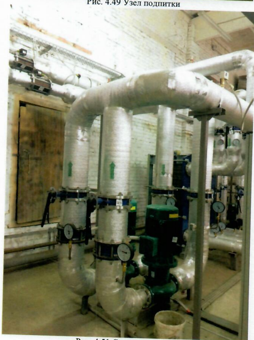
Рис. 4.51 Сетевые насосы
