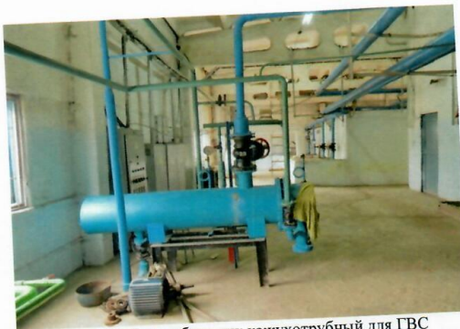
Рис. 4.123 Теплообменник кожухотрубный для ГВС
