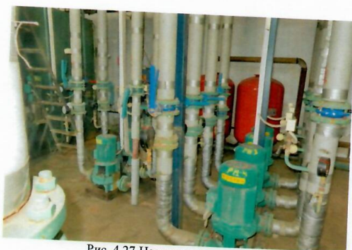
Рис. 4.27 Насосы рециркуляции
