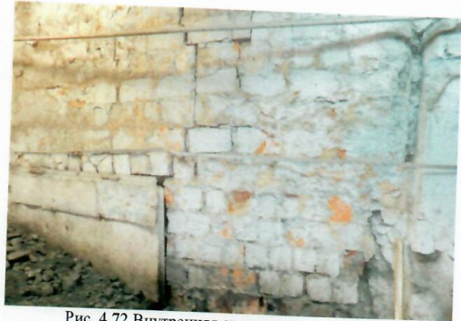
Рис. 4.72 Внутренняя стена здания котельной
