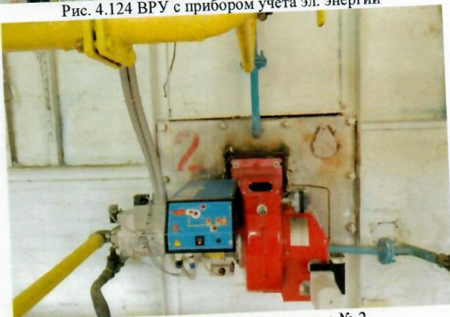
Рис. 4.126 Газовая горелка котла № 2
