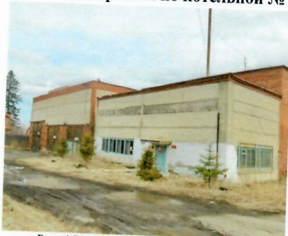
Рис. 4.79 Общий вид здания котельной
