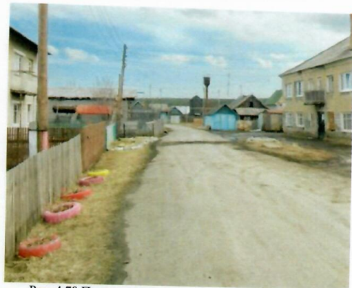
Рис. 4.78 Подземная теплотрасса, проход под дорогой
