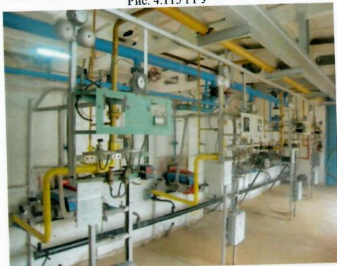
Рис. 4.117 Котлы водогрейные с газовыми горелками
