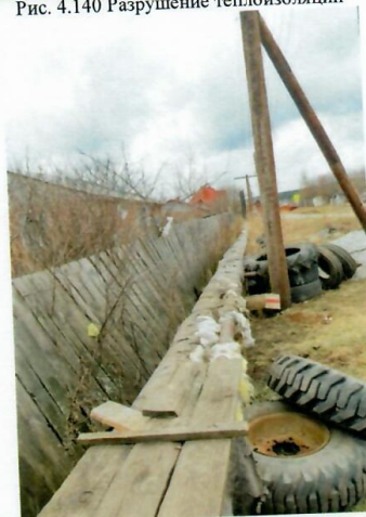
Рис. 4.142 Разрушение теплоизоляции
