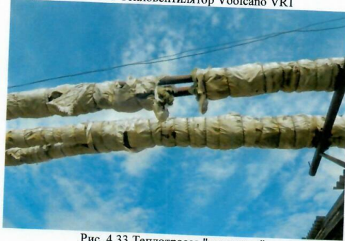
Рис. 4.33 Теплотрасса "воздушка"
