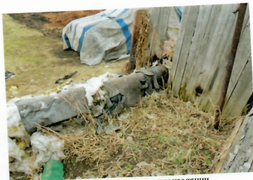
Рис. 4.140 Разрушение теплоизоляции
