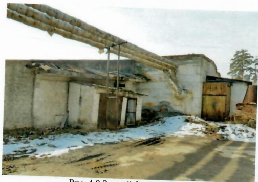
Рис. 4.9 Задний фасад здания
