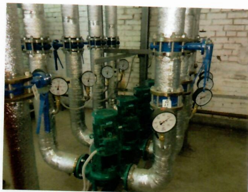
Рис. 4.54 Насосы рециркуляции
