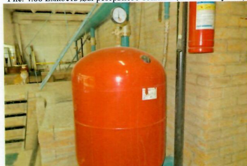
Рис. 4.90 Мембранный бак расширительный 200л
