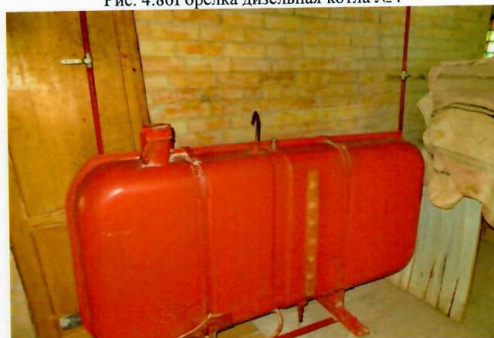
Рис. 4.88 Емкость для резервного топлива (не используется)
